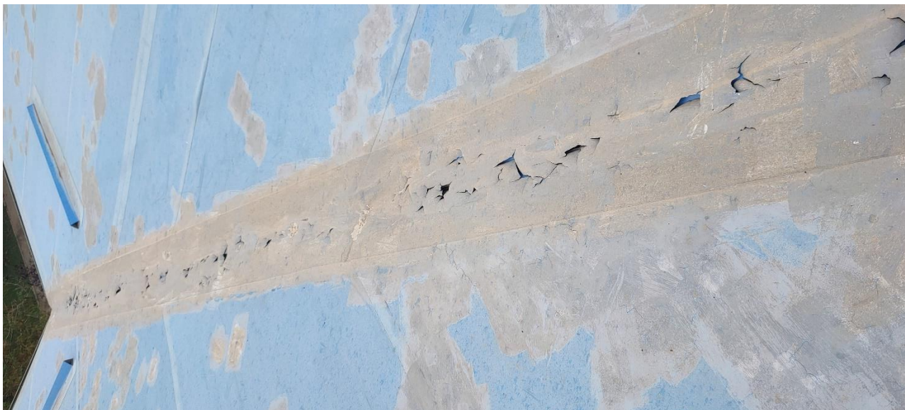
Fessurazioni diffuse in corrispondenza dei compluvi
