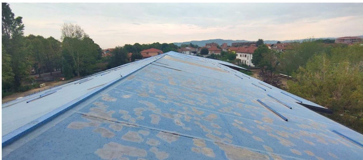
Vista di una delle falde con ammaloramenti diffusi anche in prossimità delle sovrapposizioni
