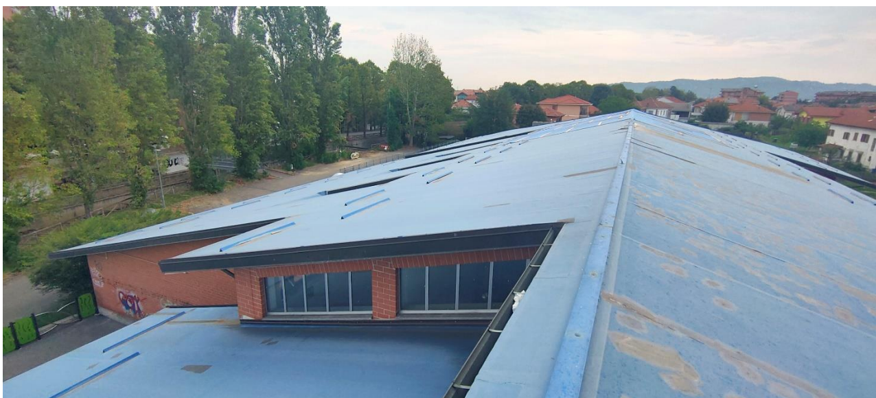
Differente stato di degrado delle falde in funzione dell'esposizione all'irraggiamento solare
